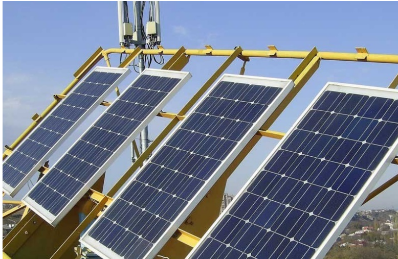
Рис.1 Панели солнечных батарей
