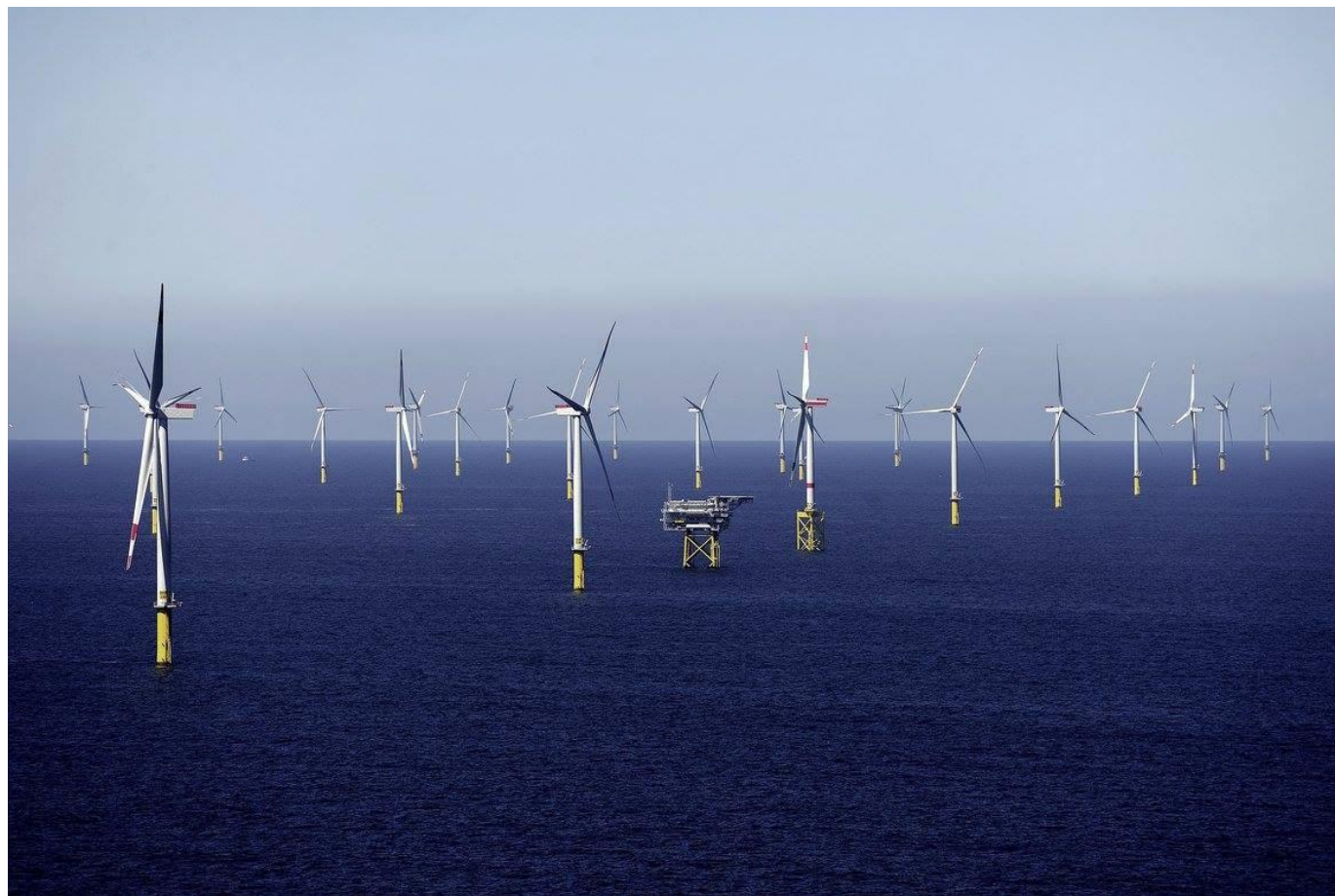
Ветряная электростанция Burbo Bank в Ливерпульском заливе, Великобритания
